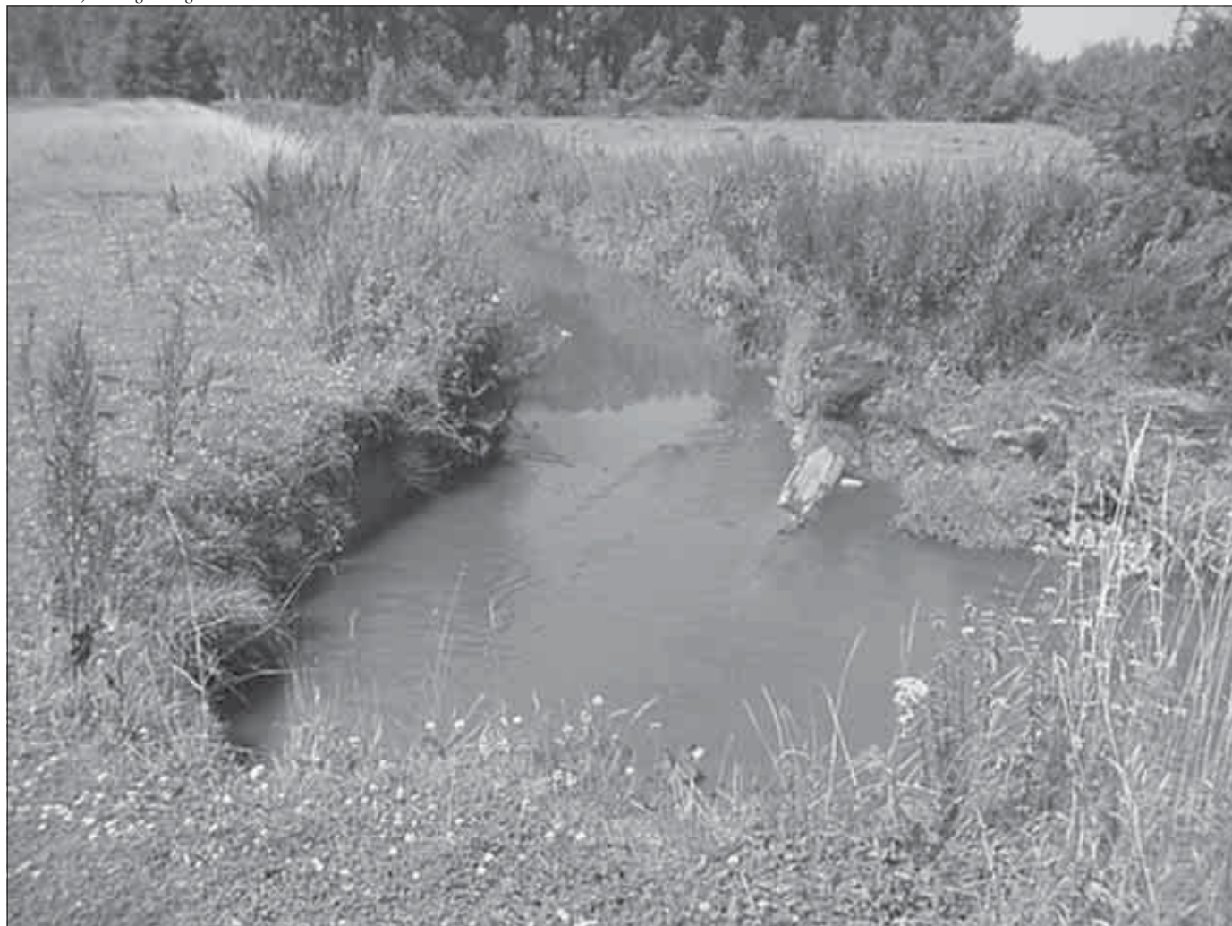
6. In het wachtbekken van Hoeleden wordt hermeandering van de Velpe gestimuleerd; door middel van het plaatsen van stroomdeflectoren (boomstam en stortsteen) en uitgraving van oude meanders
