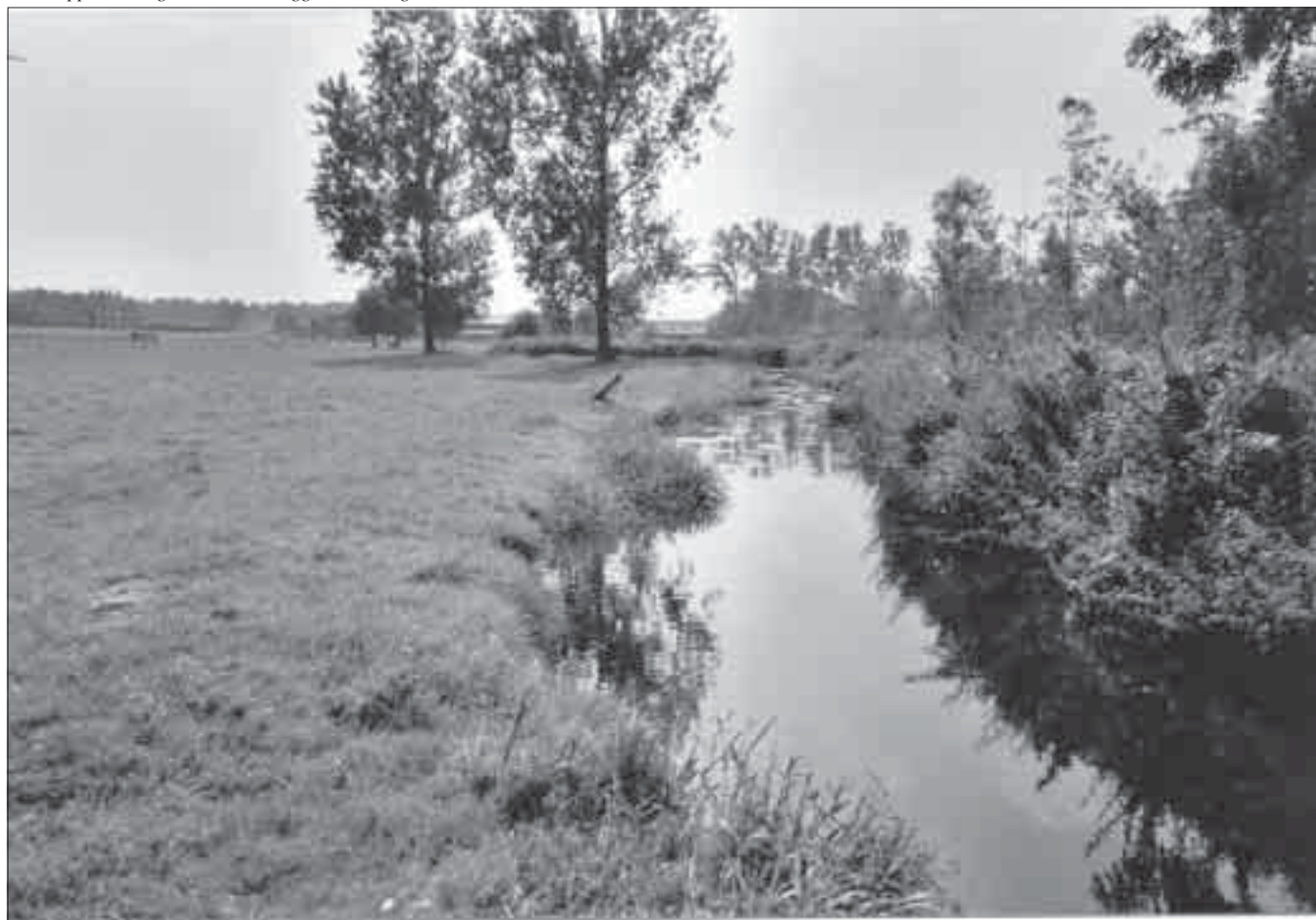
3. Om een verval te creëren voor de Dalemse molen werd de Velpe verlegd en bedijkt. Het wateroppervlak ligt steeds bijna op dezelfde hoogte als de oevertoppen en hoger dan het omliggende valleigebied.
