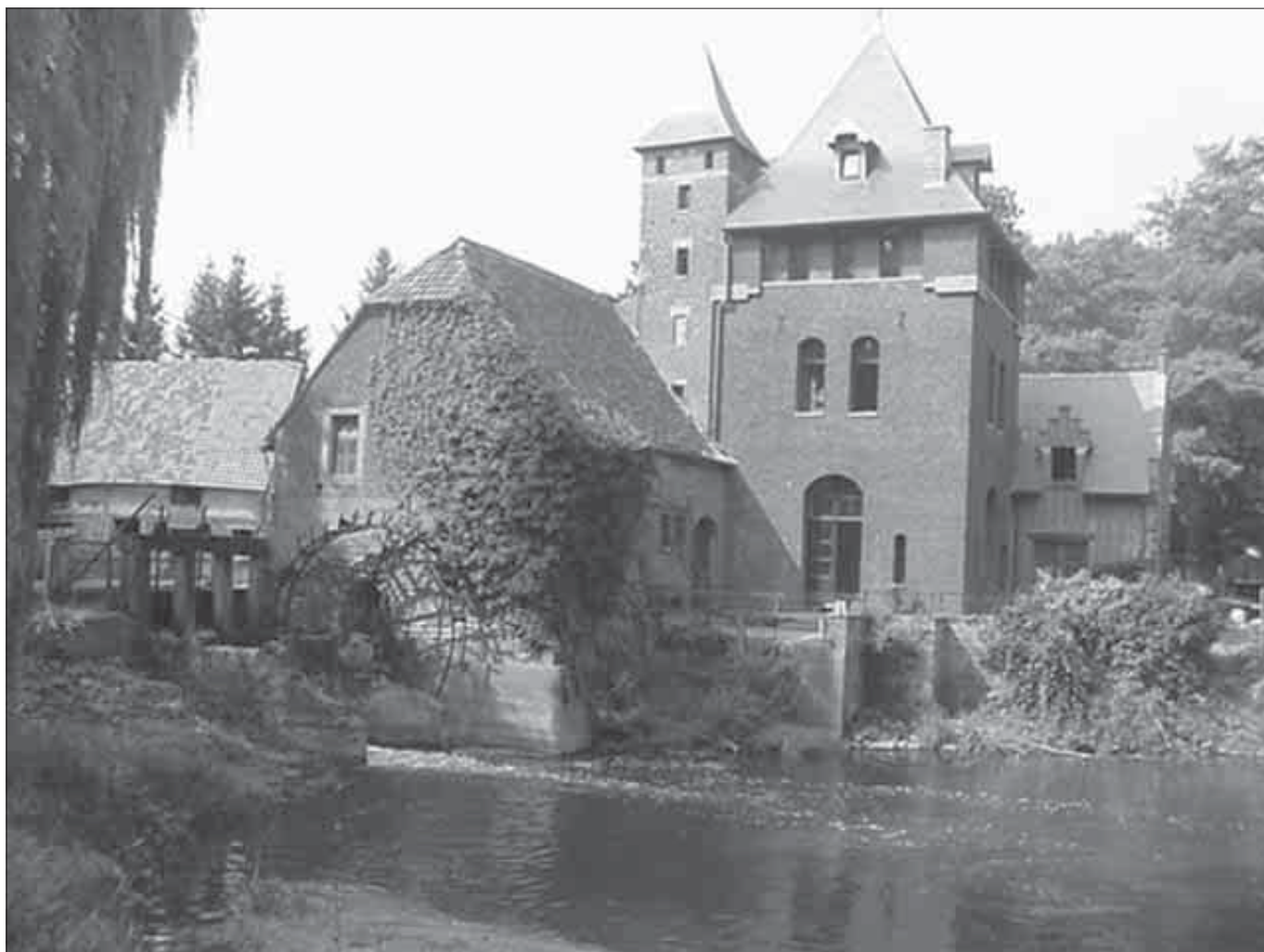
7. Het molenrad van de Rotemse molen (Loksbergen; 15e eeuw) is nog aanwezig maar niet meer functioneel. Het verval van ca. 2 m vormt een onoverbrugbare barrière voor o.a. migrerende vissen.
